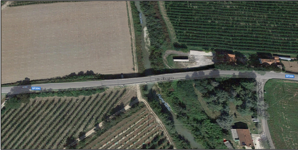
5. Vista aerea 3D della localizzazione del Ponte della Chiusa
