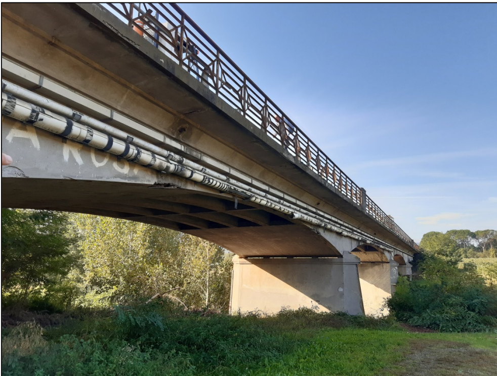
6. Vista laterale dell'impalcato del Ponte della Chiusa
